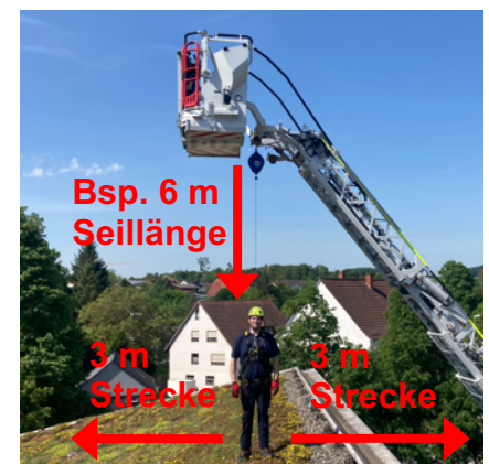
Faustformel für den Bewegungsraum wegen Winkel/ Schrägzug
